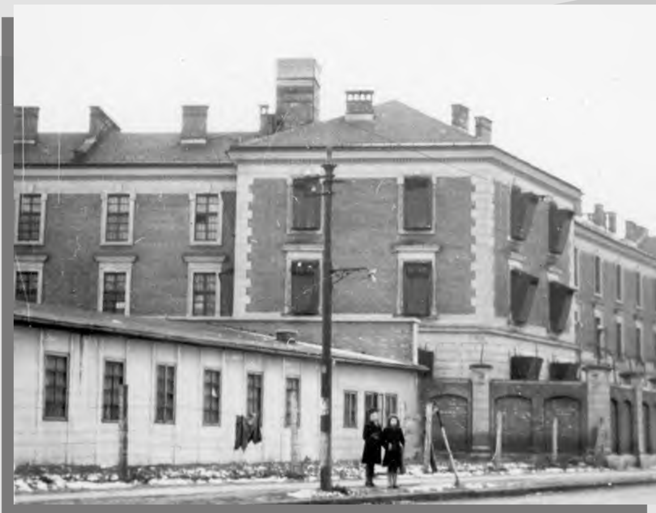
→ Gmach więzienia Urzędu Bezpieczeństwa Publicznego przy ul. Montelupich, w którym część wyroku odbywał Stanisław Mierzwa. Kraków, b.d. 📍 AIPN
