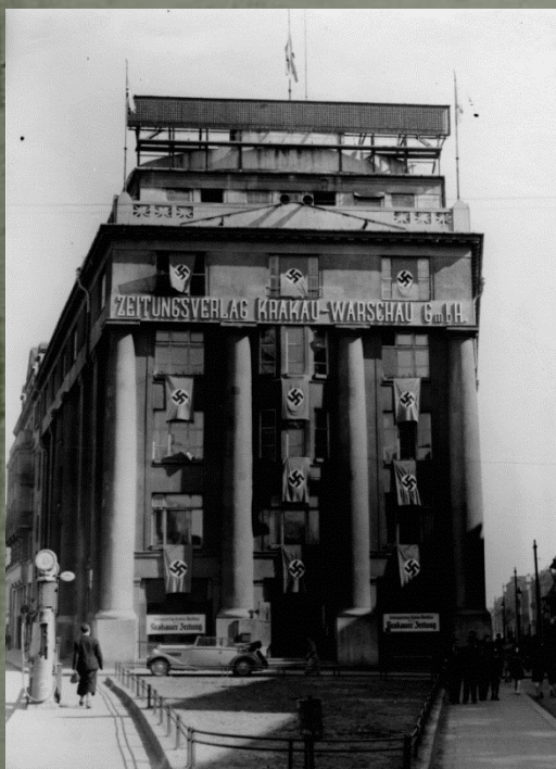
Gmach Wydawnictwa Prasowego Kraków- Warszawa. Ul. Wielopole
